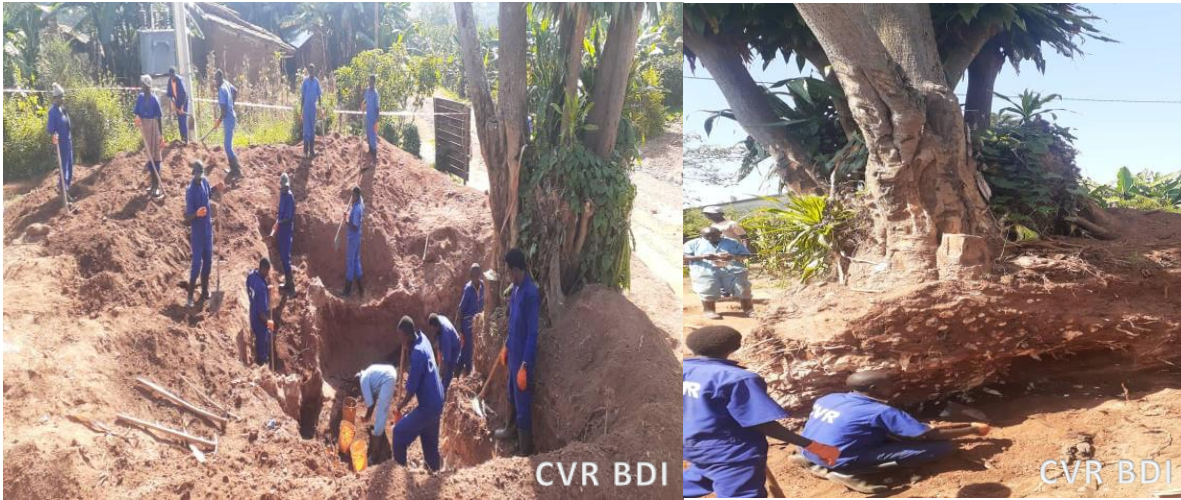
Site de Burenge commune Marangara: les manœuvres en pleine excavation de la fosse commune de Burenge.
